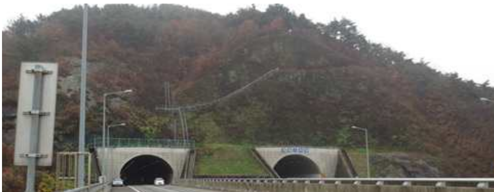
(종점부 절토사면 전경)
