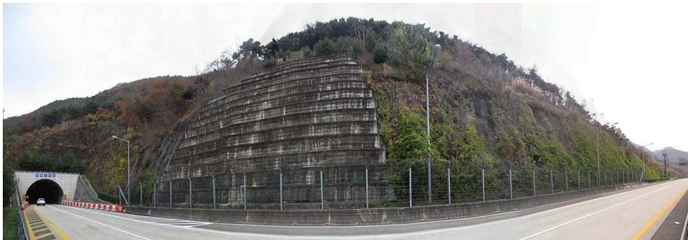
(시점부 상행선 절토사면 전경)
